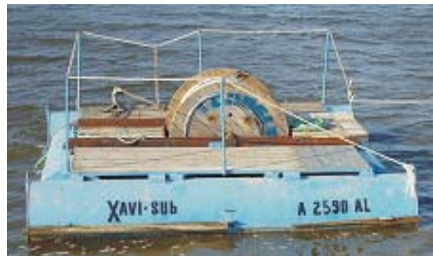
Figure 13. Floating raft used for installing the optical cable. Figura 13. Balsa flotante usada para la instalación del cable óptico.
